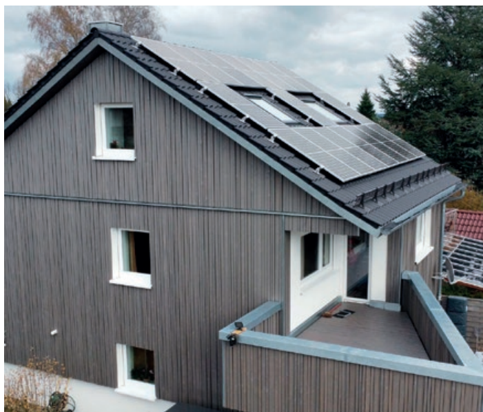
Dach- und Fassadensanierung, Balkonanbau
